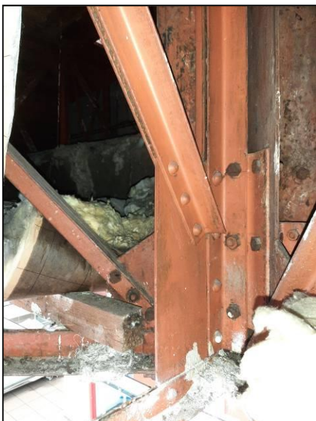
Assemblages riveté et boulonné
