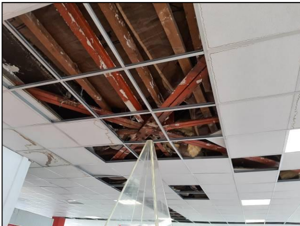
Nœud central des poutres treillis
