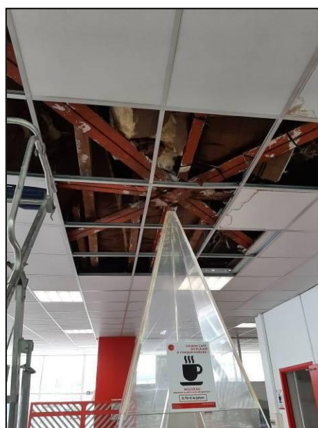
Nœud central en partie inférieure
